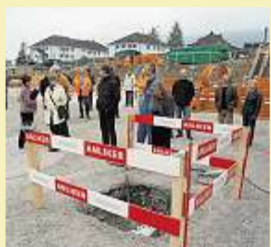
Koffer versenkt: Gestern wurde der Grundstein Brüelmatte gelegt.
